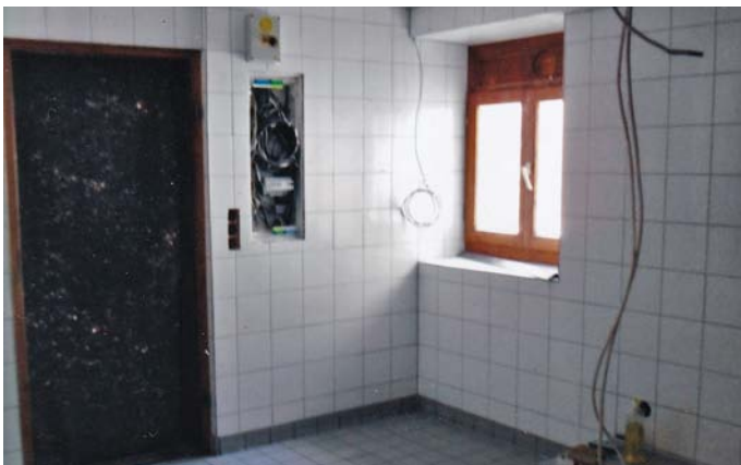
Vorgeschriebene und genehmigte Fliesen
